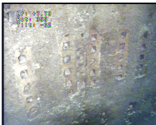
Vue sur les crépines : 7,73 m/repère
