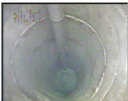
Vue sur le fond du puits : 3,1 m/repère
