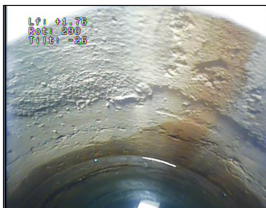
Cuvelage en béton : 1,76 m/repère
