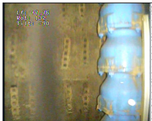
Vue sur les crépines : 7,76 m/repère
