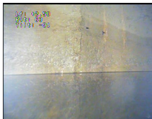
Niveau statique à 2,61 m/repère
