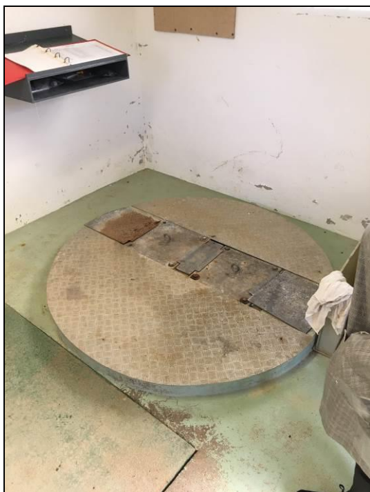
Tête du puits
