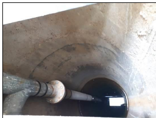
Intérieur du puits
