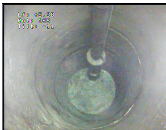
Vue sur le fond de l'ouvrage : 5,4 m/repère
