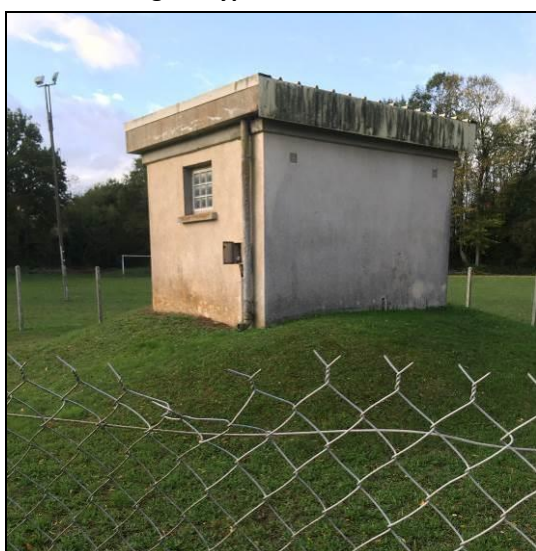
Local technique surélevé
